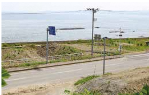
▲残土置き場予定地(前坂踏切海側)
