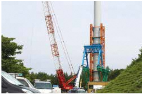
▲大型風車建設現場の様子
