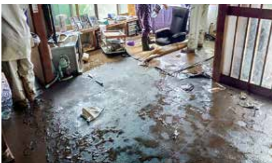
▲浸水被害のあった家屋（北金ヶ沢地区）
