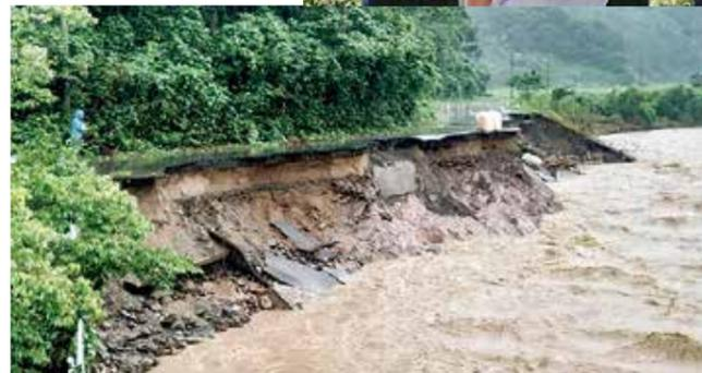
追良瀬川の増水で崩壊し、車両通行ができなくなった町道松原1号線
