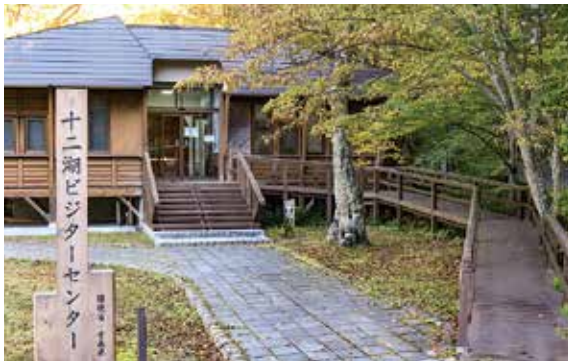
県から無償譲渡された十二湖ビジターセンター
