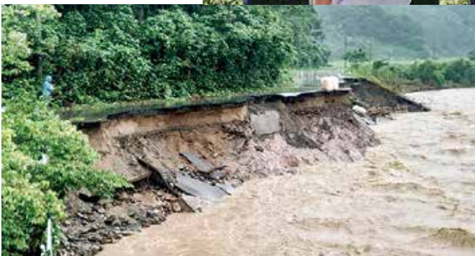
▲追良瀬川の増水で崩壊し、車両通行ができなくなった町道松原1号線
