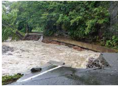
▲川の水と土石で陥没・崩落した町道長慶平1号線
