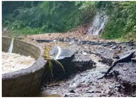
▲川の水と土石で陥没・崩落した町道長慶平1号線
