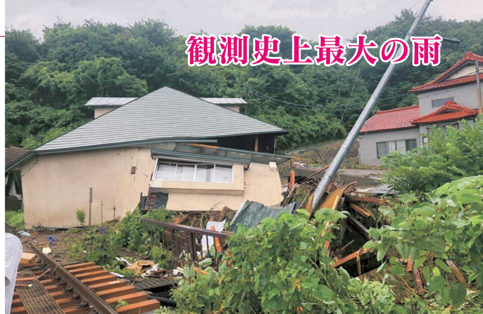
▲土砂崩れにより倒壊した家屋(田野沢)
