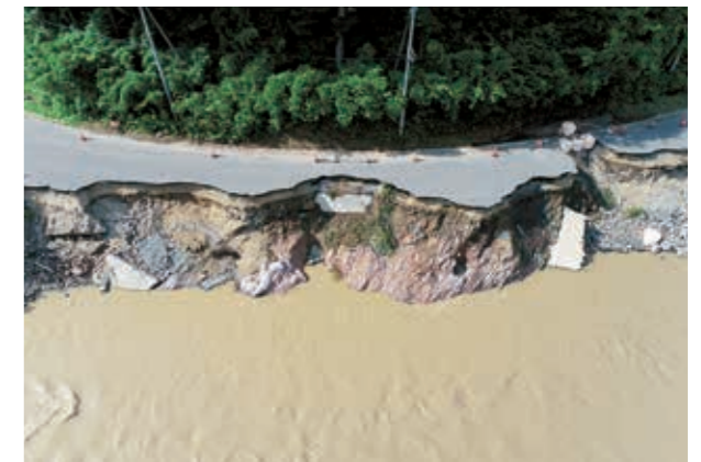
▲道路が崩落し、一時孤立状態となった松原地区
