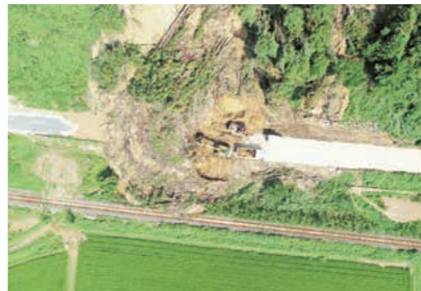
▲土砂崩れで通行止めとなった国道101号線(黒崎)
