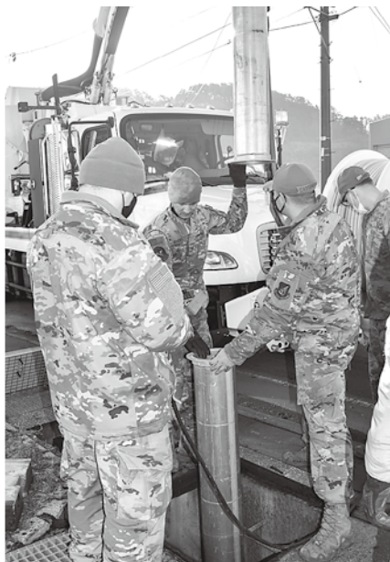
ジェット燃料の除去作業(12月9日)(陸奥新報社提供)
