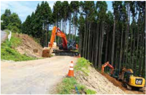
▲広域農道との接続部分を改良
