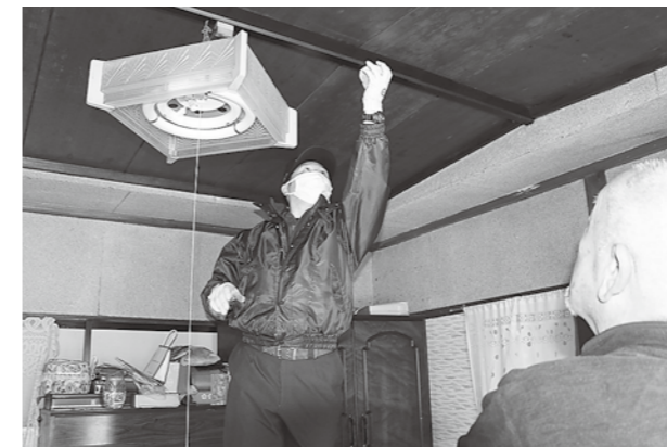
取り付け作業完了を確認
