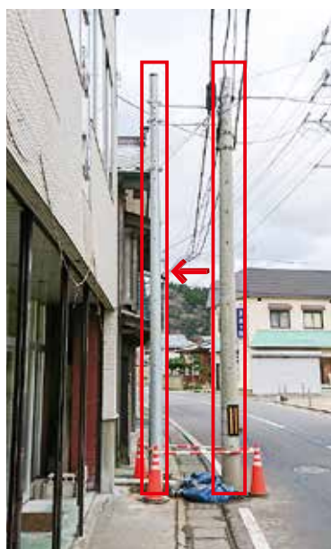
▲移設工事の状況
