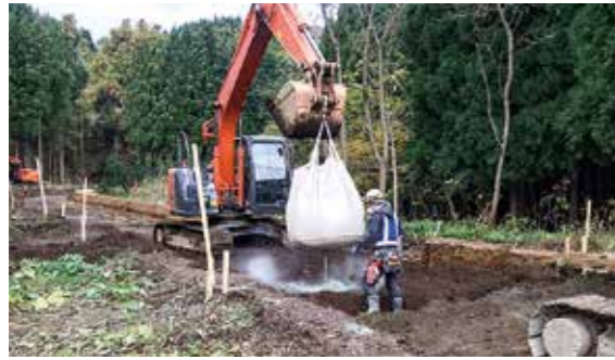
▲町道北金ヶ沢28号線道路改良2期工事
