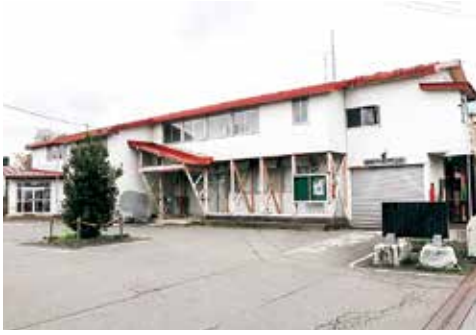
▲解体する旧大戸瀬支所(関地区)
