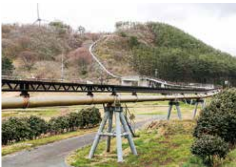
▲改修予定の展望モノレール設備(ウエスバ椿山)
