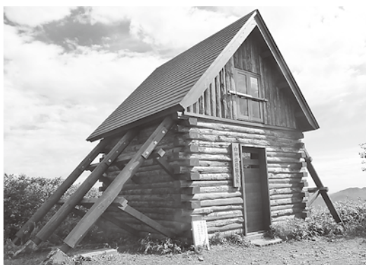
新しくなった避難小屋。ヒバの香りが疲れた体を癒します。
