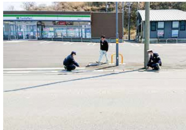
▲鯨ヶ沢警察署による横断歩道設置確認（深浦地区）
