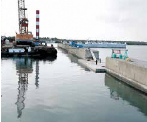
▲現在工事中の風合瀬漁港
