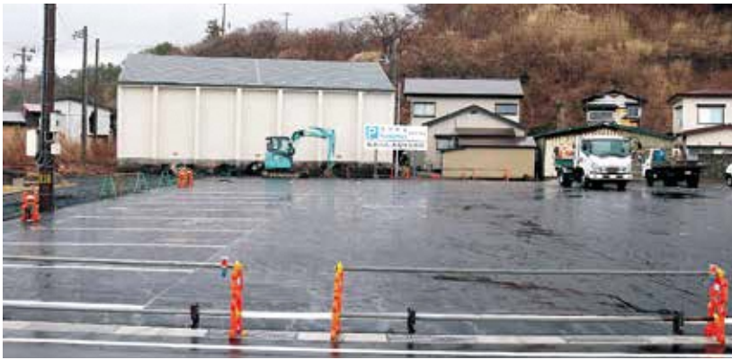
▲大岩駐車場整備の様子
