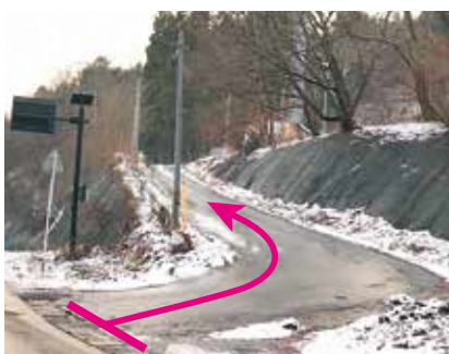
▲町道北金ヶ沢28号線起点
