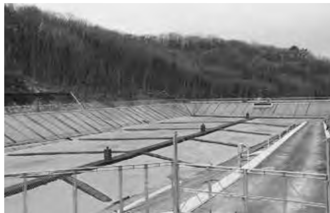
完成した一般廃棄物最終処分場
