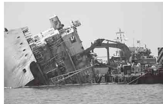
解体作業が進むアンファン号
