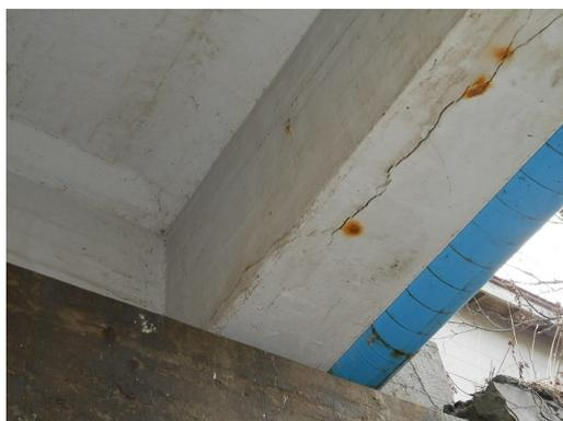
写真 3-1 塩害による損傷状況
