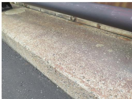
写真 3-2 凍害による損傷状況
