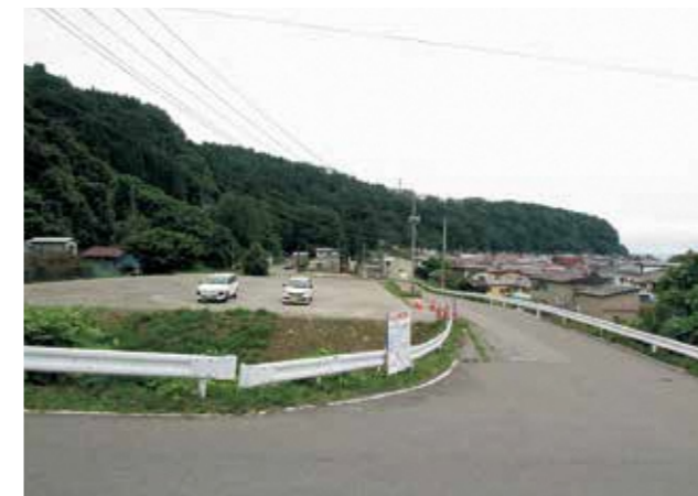
▲駐車場舗装、道路拡幅をする北金ヶ沢地区防災広場
