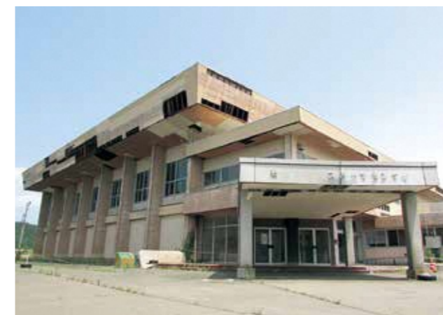
▲解体する岩崎スポーツセンター
