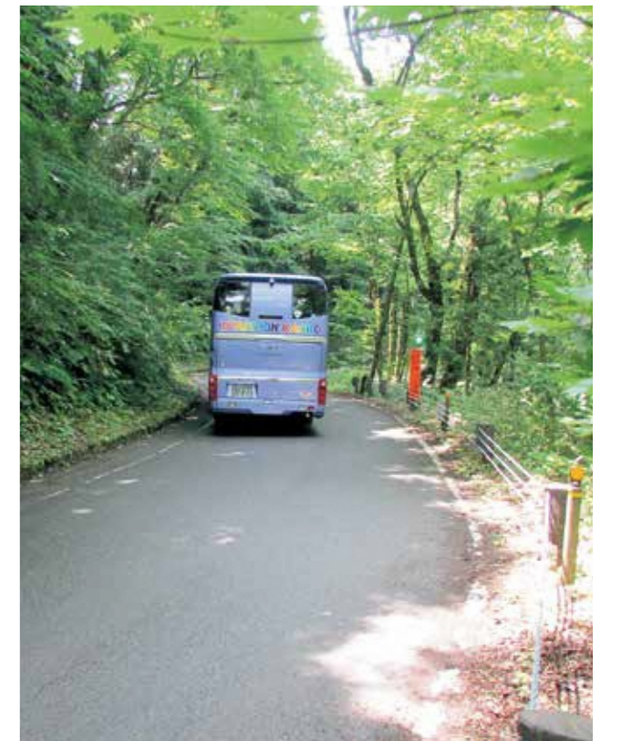
▲道路拡幅をする町道十二湖公園線(2工区) 現在、大型バスが通ると対向車がすれ違えない状況
