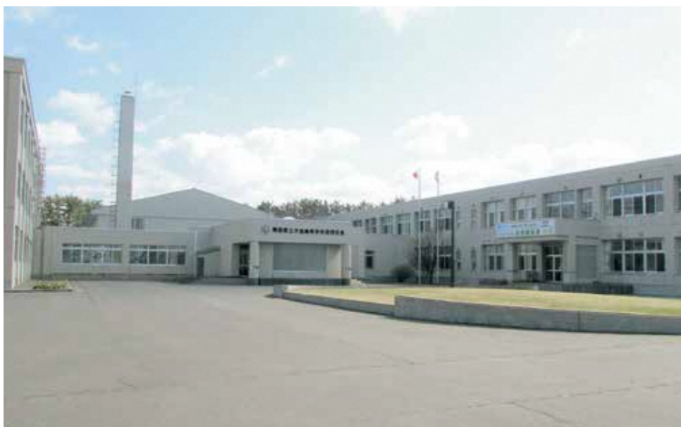
▲存続を望む県立木造高等学校深浦校舎
