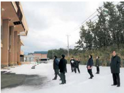
▲閉鎖された岩崎スポーツセンター
