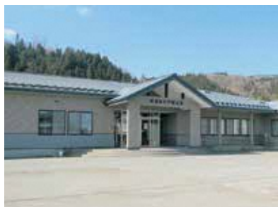
▲新大戸瀬支所 外観 （旧深浦町包括ケアセンター）
