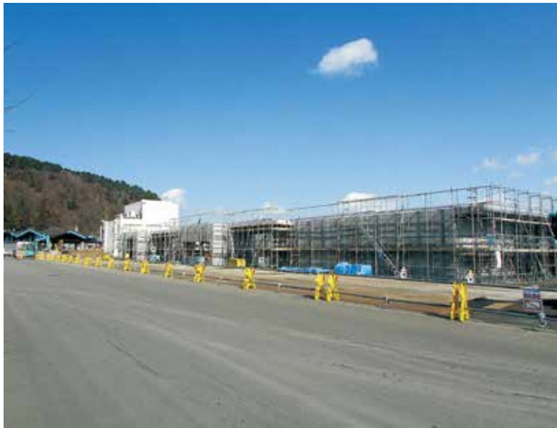
▲整備している新深浦漁協北金ヶ沢荷捌き所
