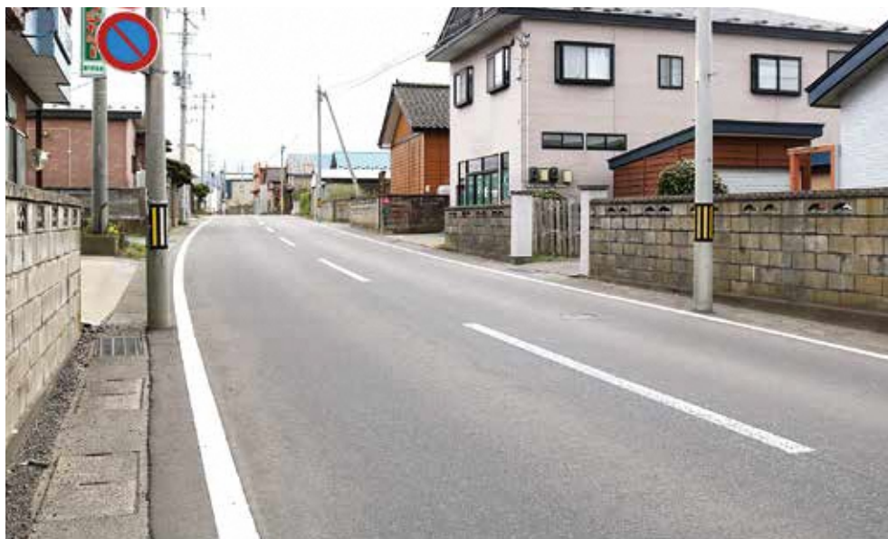
▲岩崎松原地区の国道(深浦方面から)
