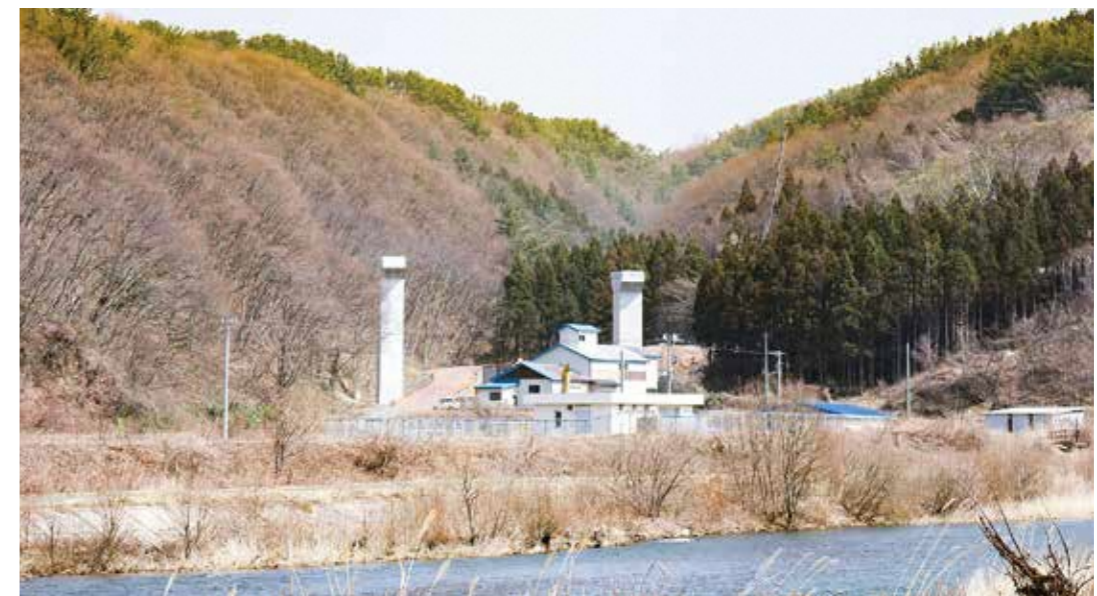
▲追良瀬バイパス2期工事
