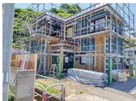
▲整備中の「お試し住宅」
