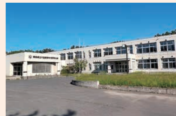
整備が始まる旧木造高校深浦校舎
