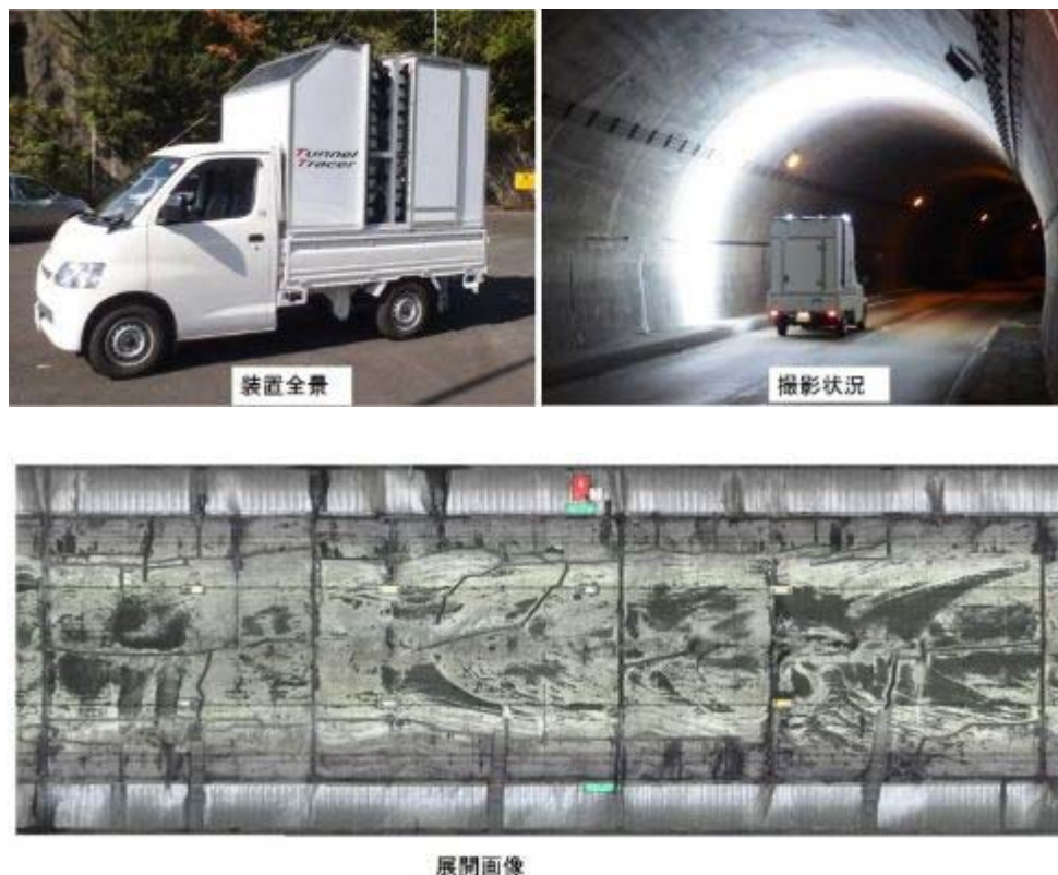
写真 4-2 新技術の点検（NETIS 新技術情報提供システム （走行型高精細画像計測システム）より
