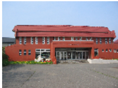
深浦町民体育館 (昭和54年3月)
