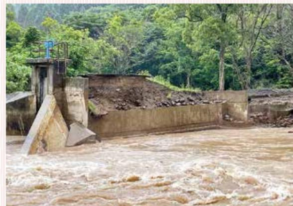
破損した追良瀬川の農業用施設（頭首工、水路）
