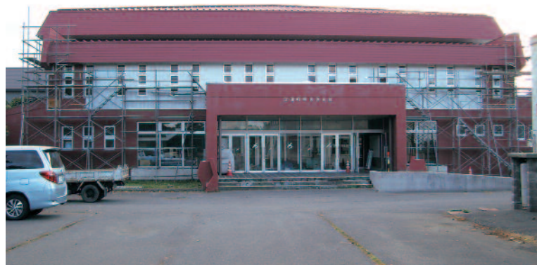
▲耐震工事を行っている町民体育館
